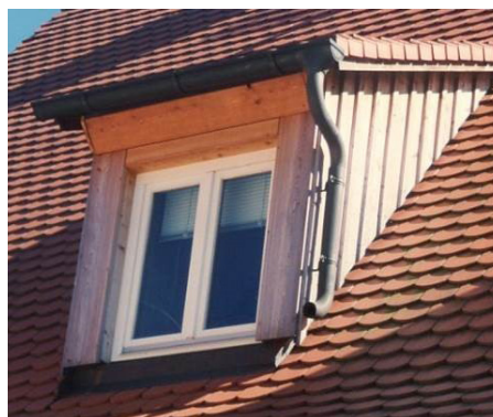
Gaubenverschalung mit Holz
