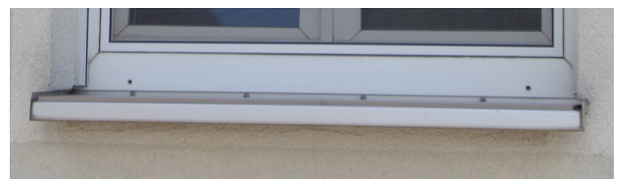
Fensterbretter aus Metall und Betonwerkstein
