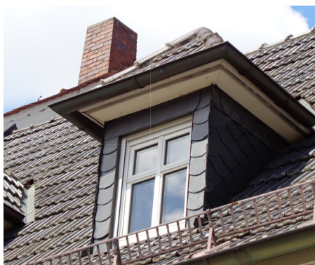
Walmdachgaube mit Schieferverkleidung
