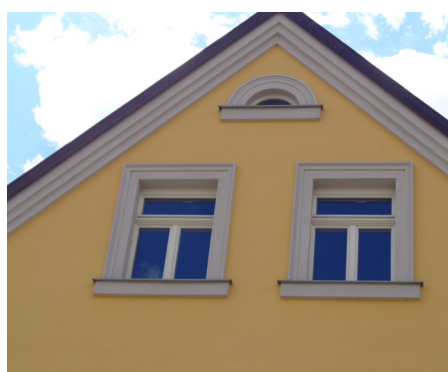
Profilierte Eckwände am Ortgang
